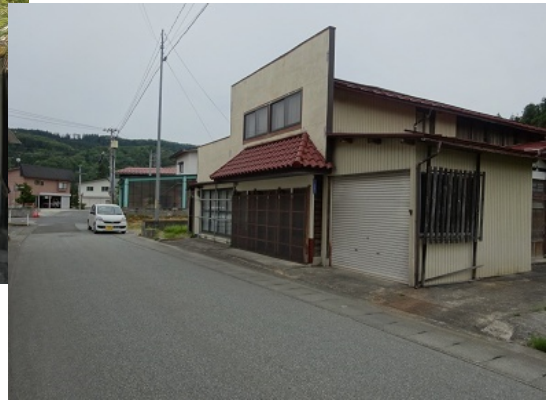
外観(南側から)
