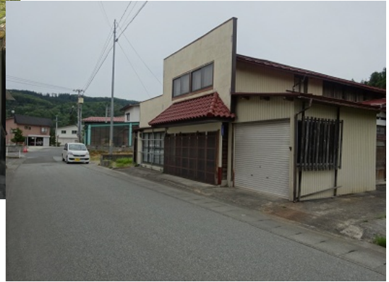
外観(南側から)
