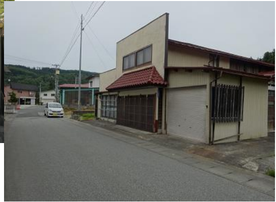
外観(南側から)
